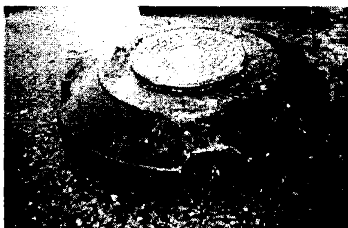
Рис. 6.10. Опорная железобетонная плита для горловин смотровых колодцев
