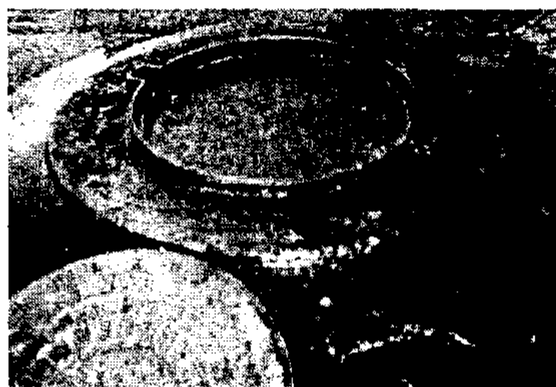
Рис. 6.10. Опорная железобетонная плита для горловин смотровых колодцев
